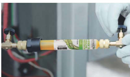
Befüllung mit dem Kältemittel
