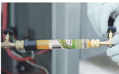
Befüllung mit dem Kältemittel
