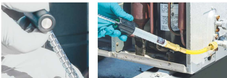
Injektion des Färbemittels durch Drehen des Griffs.
