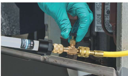
Befüllung mit dem Kältemittel
